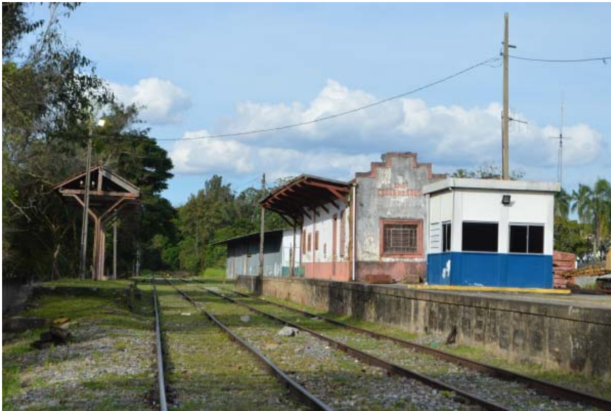
A estação de César de Souza faz parte do pacote de obras da empresa Trivia
